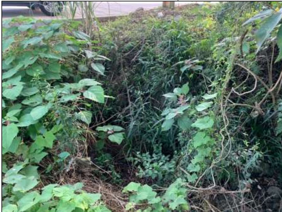
Figura 6 - Local de Saída da Canalização da Rede Pluvial.
