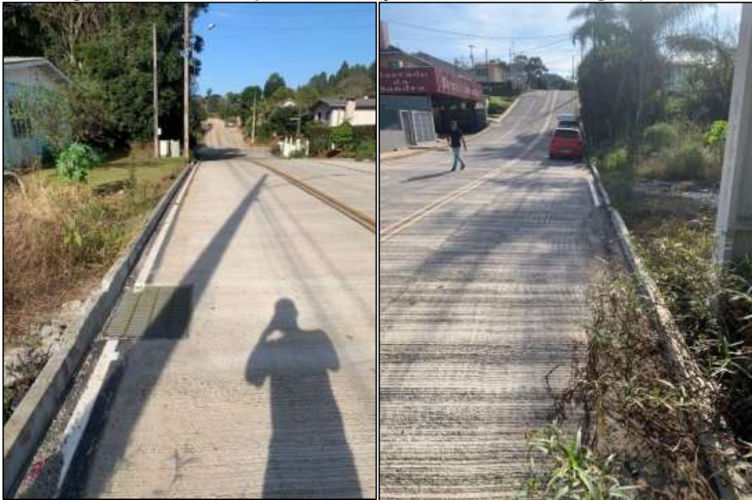
Figura 5 - Locais onde passa a tubulação com a rede de drenagem pluvial.
