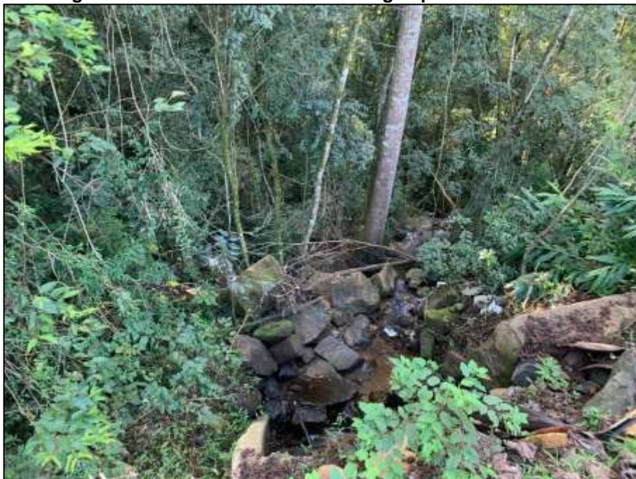
Figura 7 - Local de Escoamento da Água para curso Hídrico.
